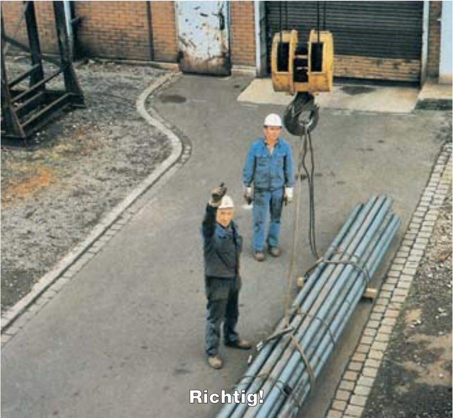
Nur er darf dem Kranführer Zeichen für das Bewegen der Last geben, nachdem er sich überzeugt hat, dass die Last sicher angeschlagen ist und die Anschläger und er den Gefahrenbereich verlassen haben. Nur auf Zeichen dieses vorher benannten Anschlägers darf der Kranführer von Hand angeschlagene Lasten bewegen.
