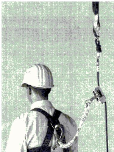
Bild 2: Beispiel des Auffangsystems:
